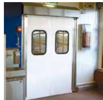
Hartkunststoff-Pendeltür mit E-Antrieb
