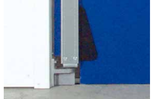
PVC-Pendeltür Detail untere Lagerung
